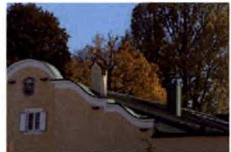
Flach geneigtes Blechdach
