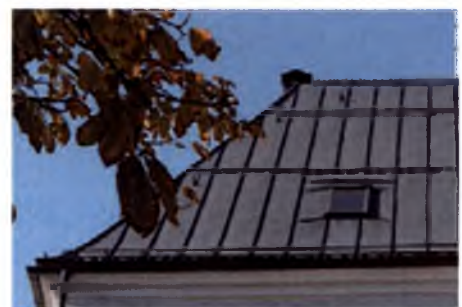
Stark geneigtes Blechdach
