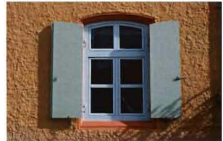
Fenster mit farbig abgesetzter Laibung
