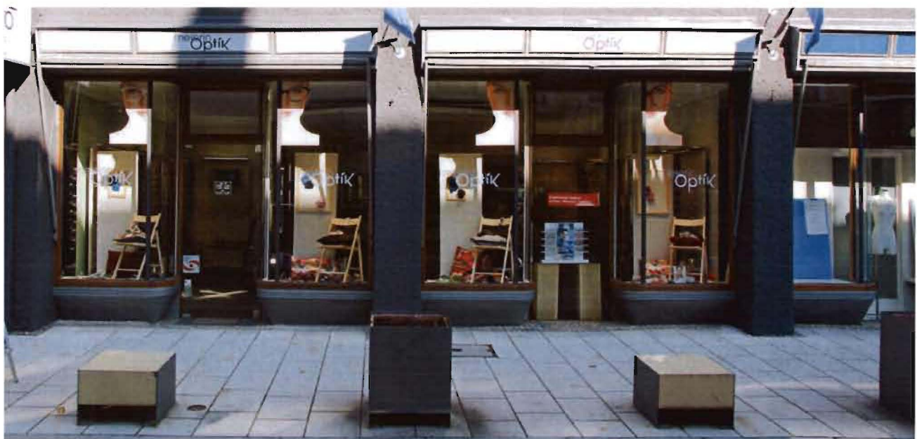
Achsen und Teilung der Schaufenster entsprechen der Proportion der gesamten Fassade
