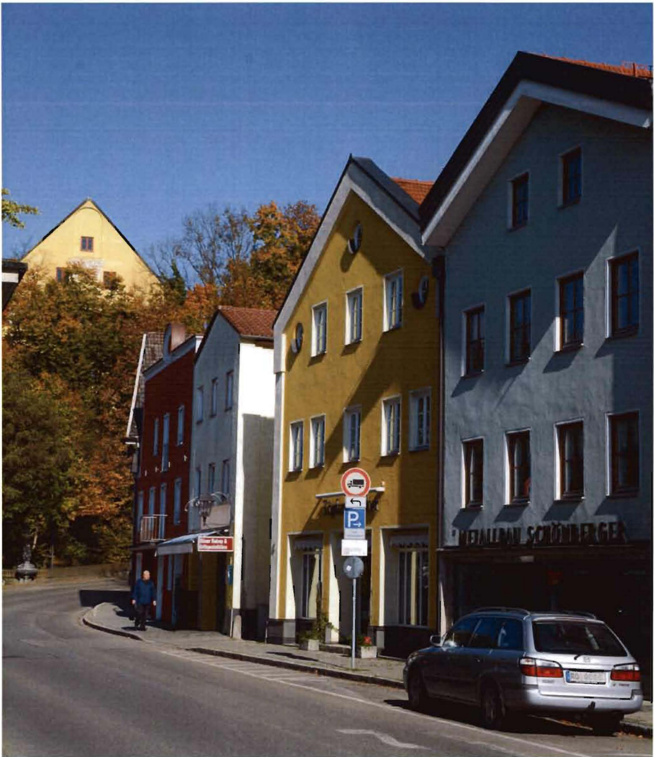
Farbige Putzfassaden entlang der Kirchzeile
